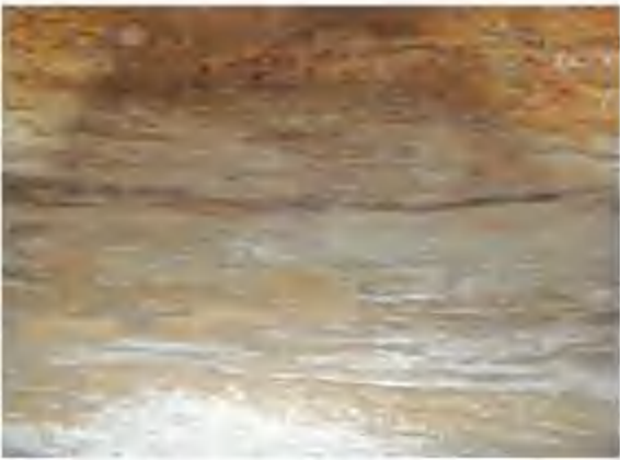
北壁岩体维修前原状
