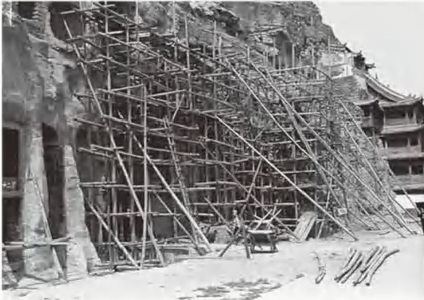
图21 云冈三年工程五华洞施工现场
