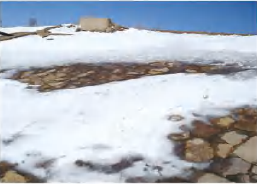
治理前西部石窟顶部
