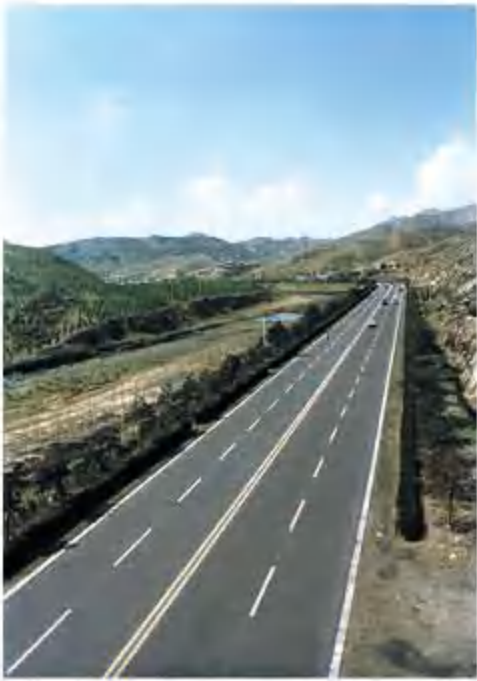
1999年109国道改线后新建的云冈旅游专线
